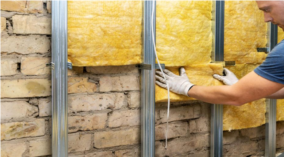
Principe de la paroi double avec laine de verre
